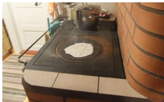
Kuva. Kakkarat paistettiin hellalla, jonka metalliosa on talon ikäinen eli yli 70 v. Hellan ringit korvattiin jo 60 vuotta sitten Kastor-levyllä. Uuni on muuten uusittu täysin
