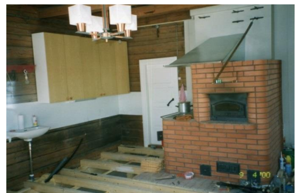
Kuva. Vanha uuni korvattiin pienemmällä leivinuunilla, Kuvassa näkyy lattian koolaus, jonka alla ilmarako ja betonilaatta
