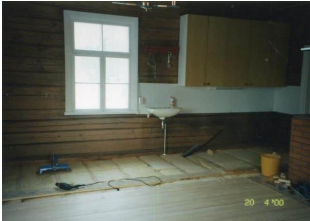
Kuva: Lattian laudoitustyö meneillään. Koolauksen välissä on lämpöeriste ja sen alla tuuletusrako
